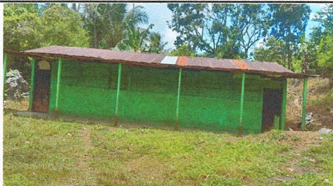
Foto 1: Vista panorámica estado actual de cubierta de lamina de escuela.
